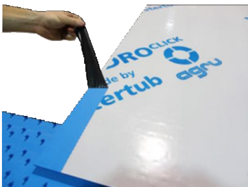
Figura 4: Scoaterea peliculei de protecție în zona de sudură
