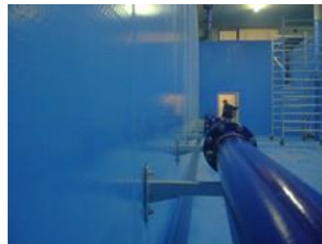
Figura 36: Linia de țevă montată de către ancora BA
