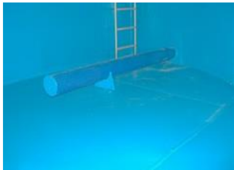
Figura 43: Susținerea țevii cu țeava PE
