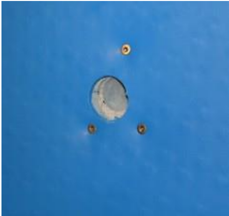
Figura 31: Gaură de foraj prefabricată.
