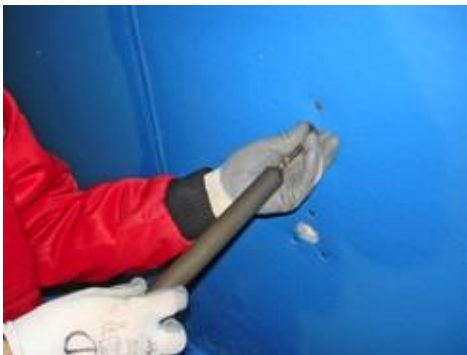
Figura 32: Asamblarea cartușului de rășină
