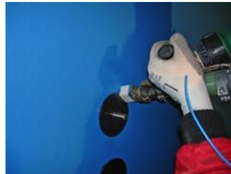
Figura 35: Sudarea prin extrudare a ancorei BA montate
