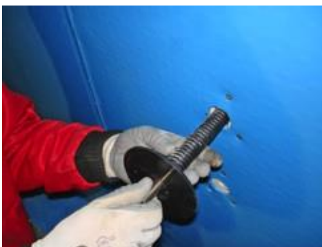
Figura 33: Asamblați cu atenție (înșurubați) rășina din plastic.
